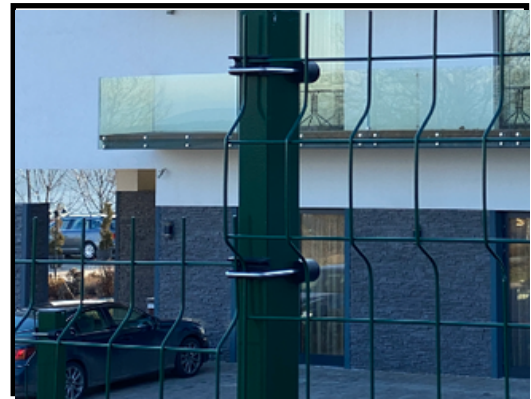
Lépcsőzés esetén ajánlott a fent látható rögzítési mód a biztos befogás érdekében.
